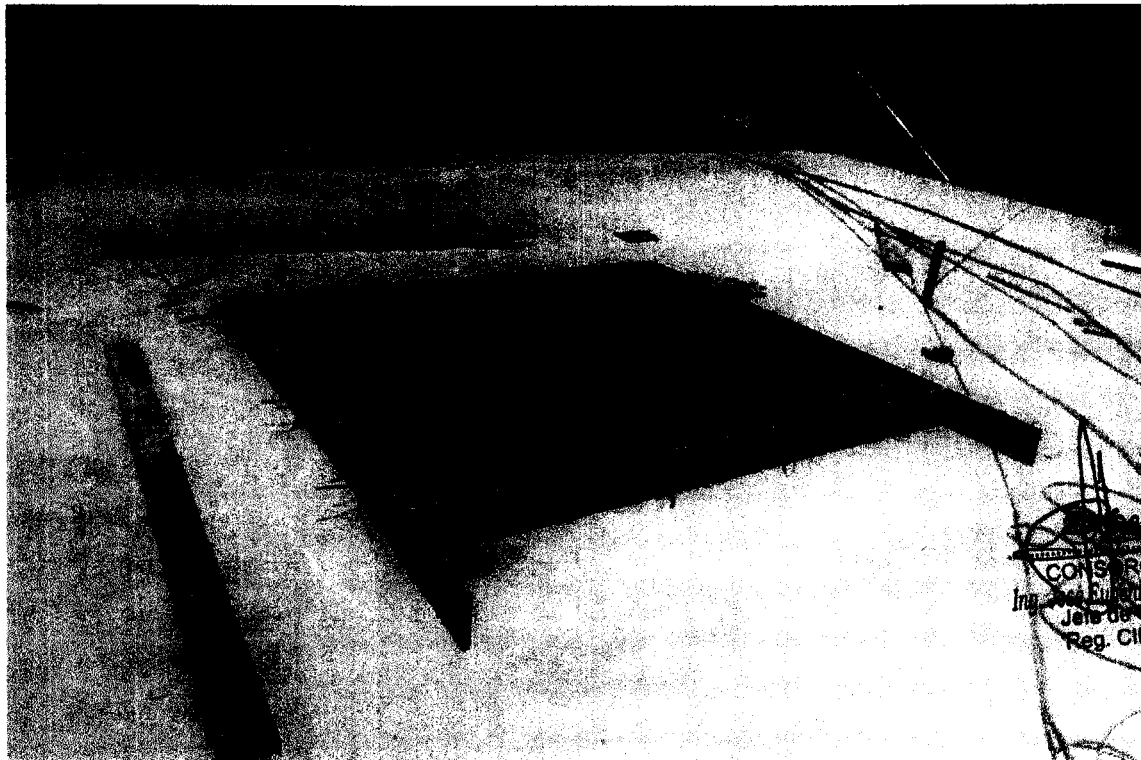
FOTO N° 010 SE OBSERVA TRABAJOS DE ENCOFRADO Y HABILITACIÓN DE ACERO 3/8" PARA TEATINAS EN 2DO. PISO ZONA DE TERRAZA.
