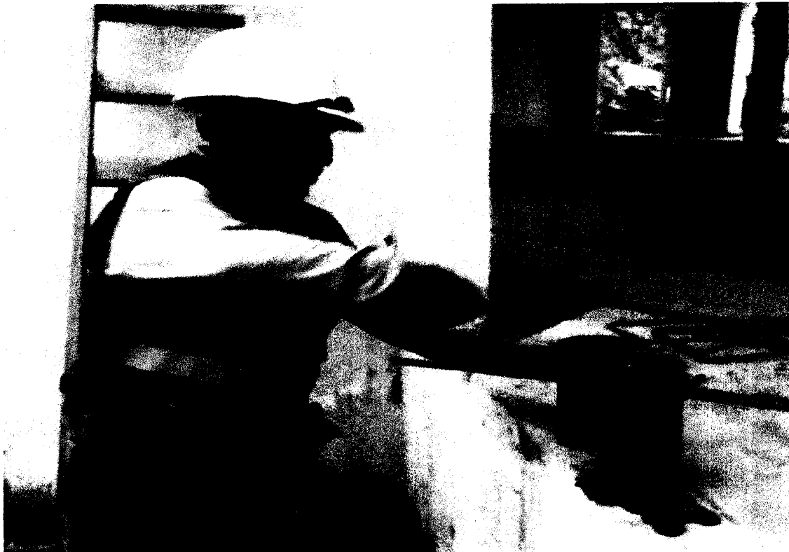
FOTO N° 006 SE OBSERVA AL MAESTRO DE OBRA SACANDO MUESTRAS DEL SOLADO PROBETAS PARA LABORATORIO
