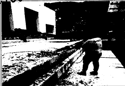
16.- Corte del borde del muelle marginal
