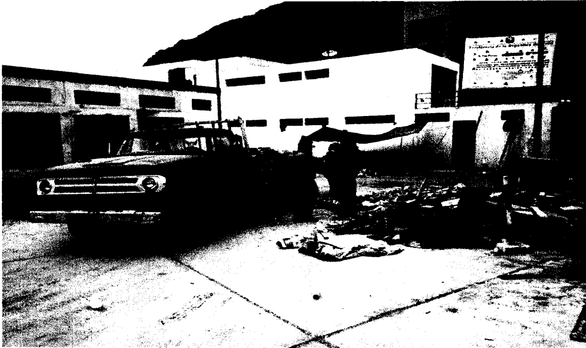
FOTO N° 001 SE OBSERVA LIMPIEZA DE MATERIAL DE CONSTRUCCIÓN.
