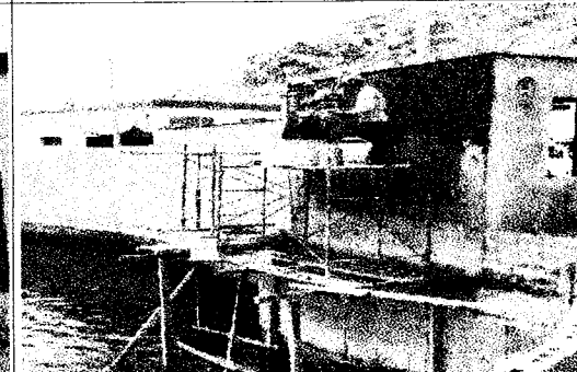
12.- Tarrajeo de paredes exteriores de caseta de vigilancia.
