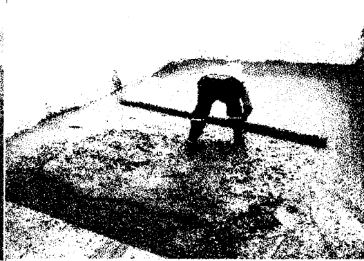
02 - Vaciado de solado en cámara de frío de 5 TN.
